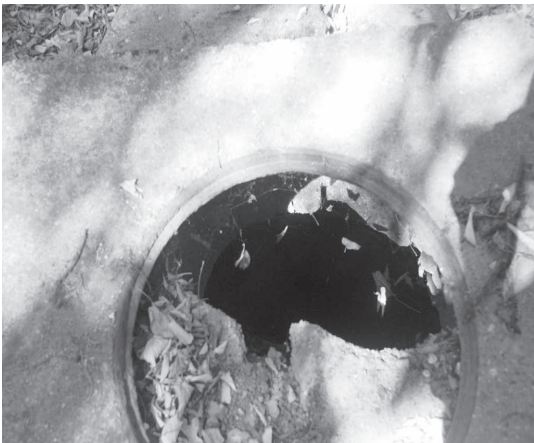
Полупани шахт и новосаграђени - Az összetört és az újjáépített akna
